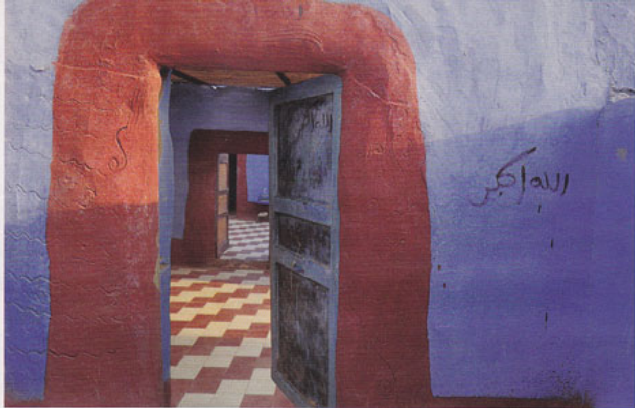
Pas un gramme de ciment, rien que de l'argile crue ou cuite, chaulée. A l'approche d'Assouan, le bateau longe un chapelet de hameaux à l'architecture typiquement nubienne.
